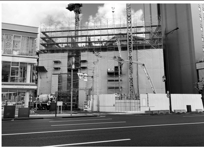
新潟駅近くでマンション工事が進む
