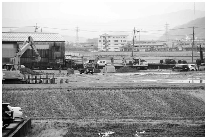
福井IC近くで物流倉庫の建設進む
